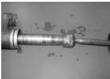
③ブーツを外すと、切れ目から入り込んだ水による錆が。
